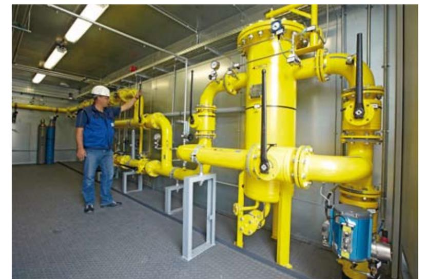
In der Biogaskonditionierungsanlage wird das Gas so aufbereitet, dass es die gleiche Qualität hat, wie das Erdgas im Netz.
