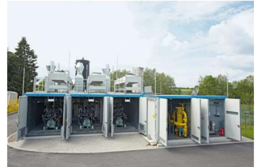
Blick in die Biogaseinspeiseanlage in Horn-Bad Meinberg. Hinter den Toren sind links die drei Verdichter, die Biogaskonditionierungsanlage und die Odorierungsanlage (rechts) zu sehen.
