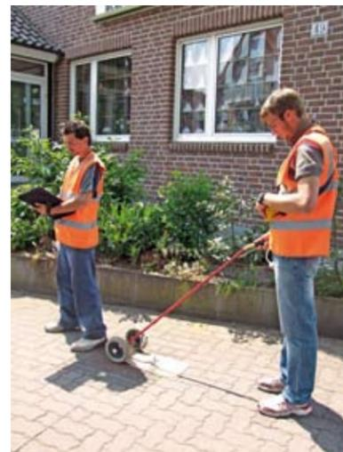
Gasspürer überprüfen die Gasleitungen mit einer „Teppich-Sonde“ auf undichte Stellen.
